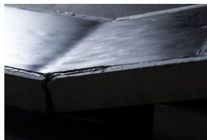
傾斜に対する施工性の検証
