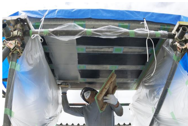
「APLAS シート工法」による施工試験の様子
