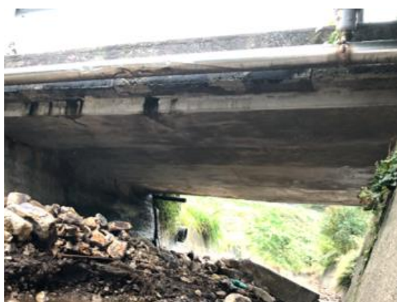
補強工事前の山田橋
